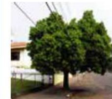
CONFLITO COM A REDE DE ENERGIA
